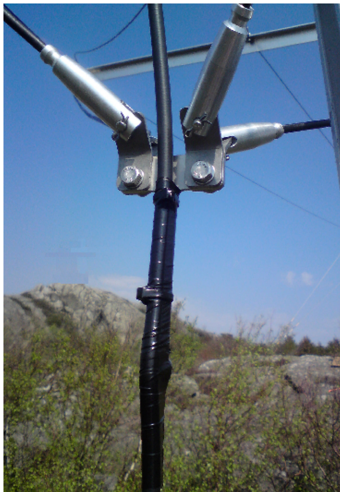
Fig. Dragavlasta koaxialkabel mot kabelstöd. Använd buntband och tejp av god kvalitet. Börja tejpa i nederkant och linda uppåt.
