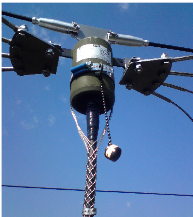
Fig. Dragavlastning för koaxialkabel. Transformator typ 400 W (samma diameter som utförande för 1 kW).
